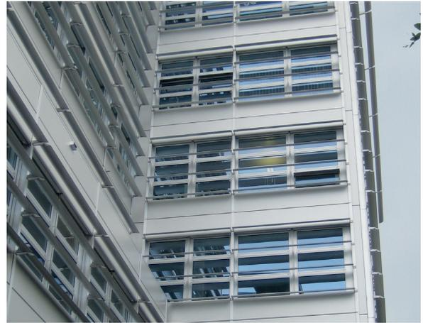
Abb. 7: Fassadenverkleidung mit eloxiertem Aluminium
